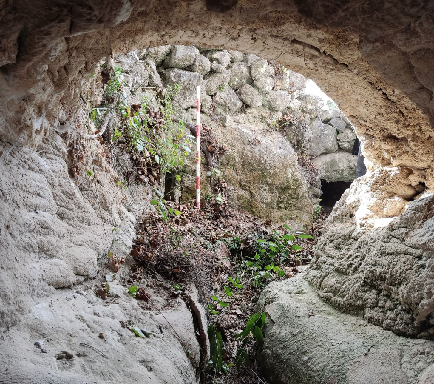
Detalle del socaz y cárcavo del Molino de la Virgen
